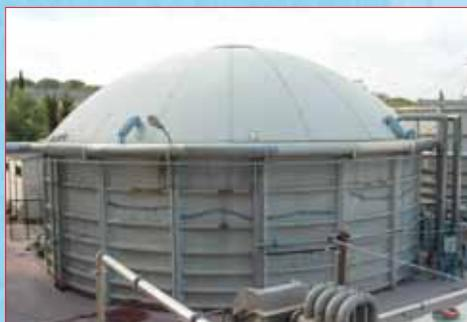
**Per il contenimento delle emissioni di sostanze maleodoranti e nocive negli impianti di depurazione:**
