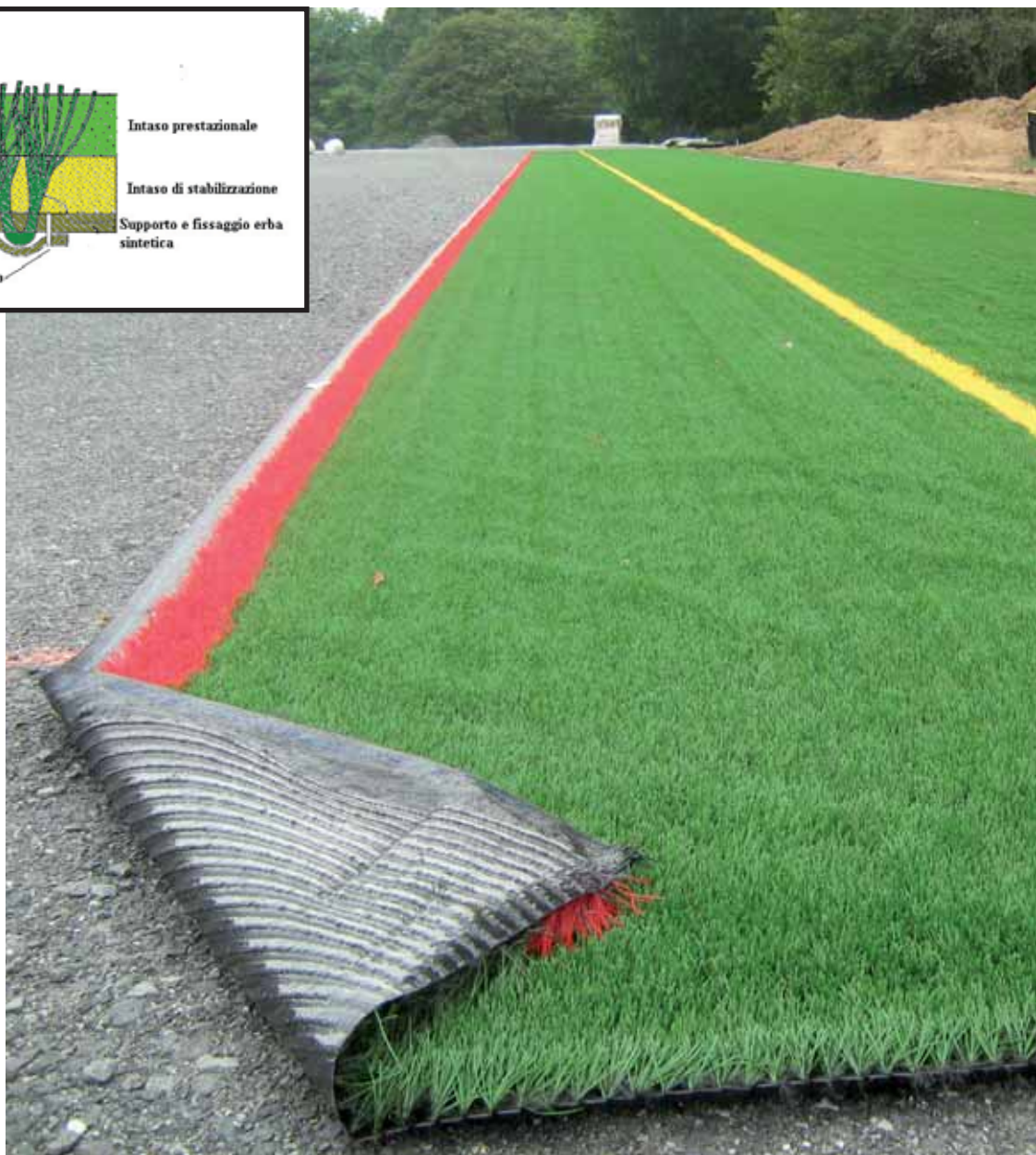
Figura 2 - Struttura generale di un campo di calcio in erba sintetica di terza generazione.
