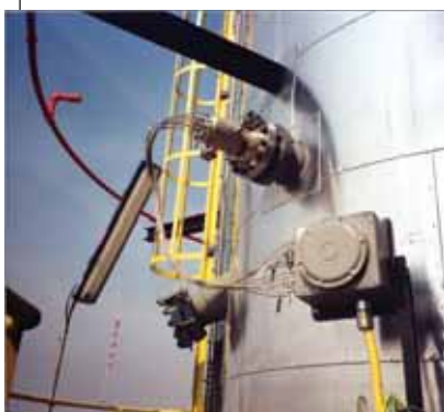
Figura 4 - Sistema Octoplus, particolari di montaggio: a) attacco al processo con camera di sicurezza (in alto al centro); junction box per il collegamento dei sensori termometrici (in basso a destra); b) il fascio di pozzetti termometrici entranti da un singolo bocchello; c) la struttura di sostegno del sistema autoportante; la sagomatura dei termoelementi per raggiungere i punti di misura.
