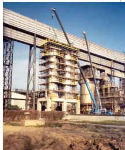
Figura 3 - Reattori di idrodesolforazione installati presso una primaria raffineria in Italia.
