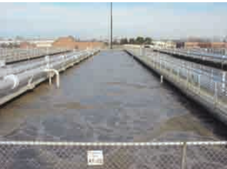
Figura 1 - Miscela aerata e acque filtrate in un processo Mbr.
