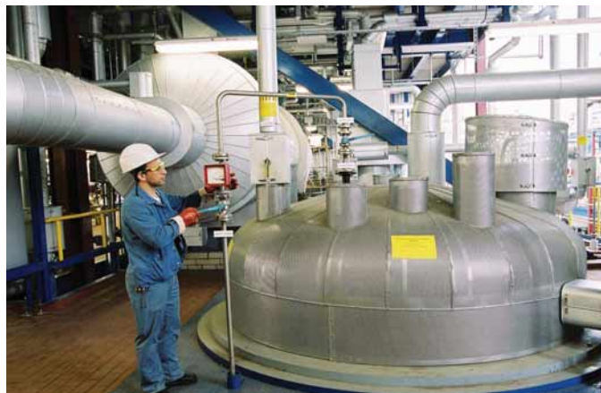
Controllo del flusso di azoto nel serbatoio di neutralizzazione presso lo stabilimento di produzione di Tda nel Chemical Park Bayer a Dormagen
