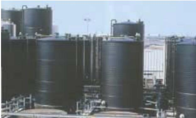
specifico sistema di estrusione-rotazione senza alcun tipo di saldatura realizzato in polietilene o polipropilene, scelti in funzione del liquido da stoccare e della temperatura di esercizio.
