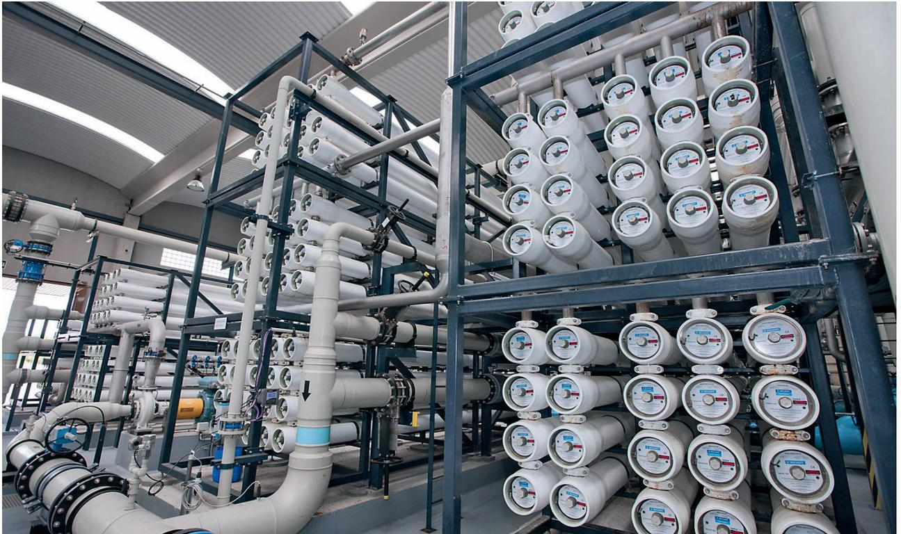
^ Gli elementi a osmosi inversa Filmtec di DOW Water & Process Solutions sono stati selezionati per essere installati nell'impianto di riutilizzo in base allo schema di pretrattamento di Veolia
